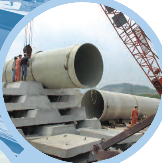
海底Block设置(上端施工)
