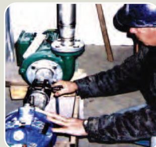
▲ 高压泵.送水管修复工程
