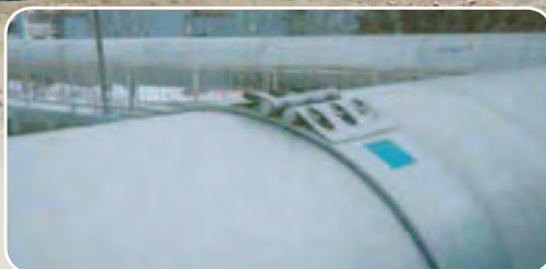
▲ 48" (1, 200A) YN MF-RL 加拿大发电厂冷却线
