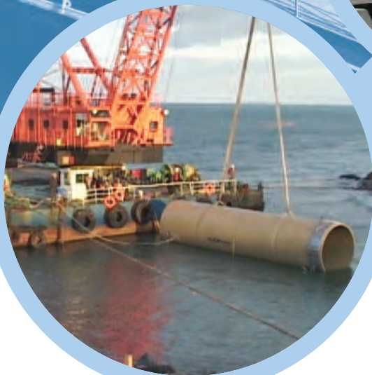
依靠潜水员正确安装
