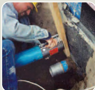
▲ 美国下水道修复工程
