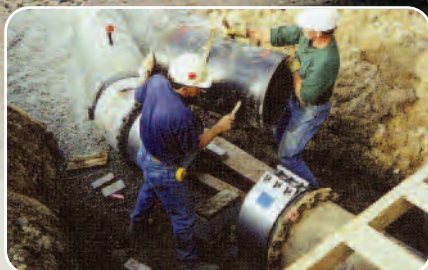
▲ 地下管道交替修复工程
