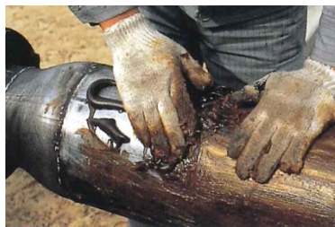
b. Application of plastelen AQ primer
