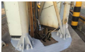
钢结构防腐密封保护
