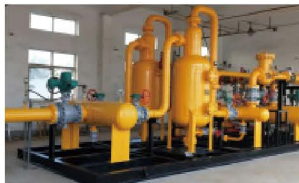
阀室管道及异型设施防腐
