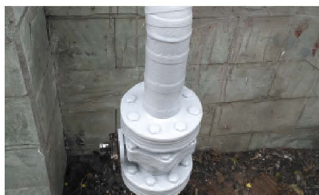
法兰、场站防腐应用案例
