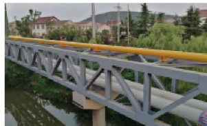
过桥管防腐保护
