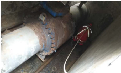
北京燃气调室应用 (防腐前)
