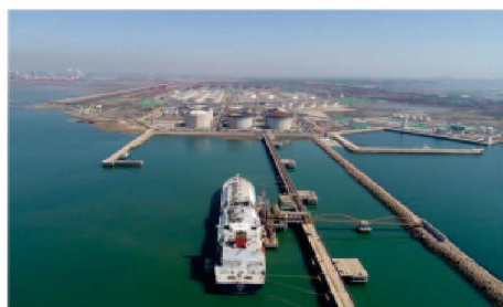
Corrosion prevention for LNG storage tank
