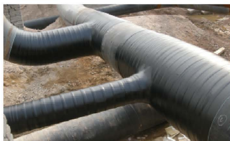
埋地三通、弯头防腐应用案例
