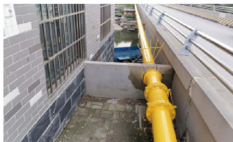
过桥、架空、出汗管防腐应用案例
