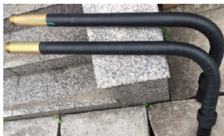
钢塑转换、出入地管防腐应用案例
