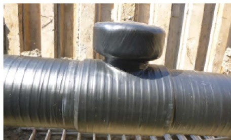
埋地法兰、阀门防腐应用案例
