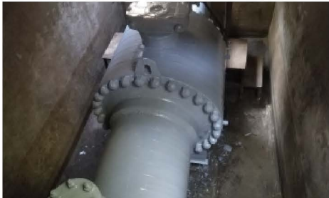
北京燃气调室应用 (防腐后)
