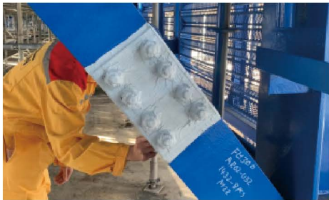
台湾台塑工厂螺栓防腐
